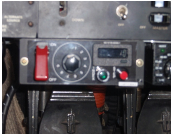
Instalación caja control.
