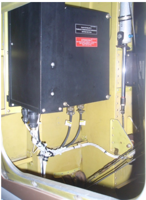
Instalación caja relays y fusibles sectorizados.
