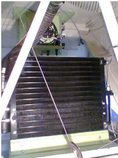
Instalación U.C. y Evaporadora
