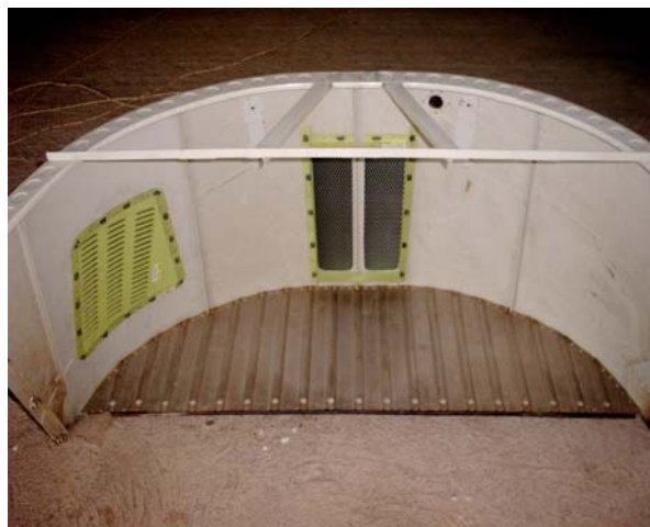
Instalando Ventilaciones Unid. Condensadora
