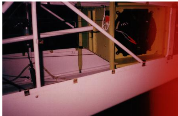
Montaje Unidad Condensadora
