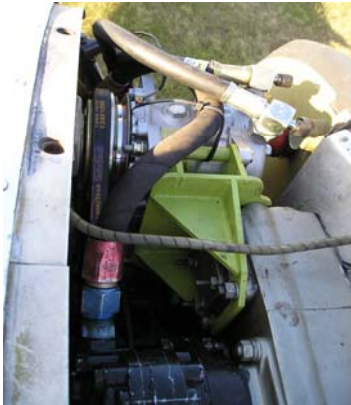
Instalación Compresor A/C
