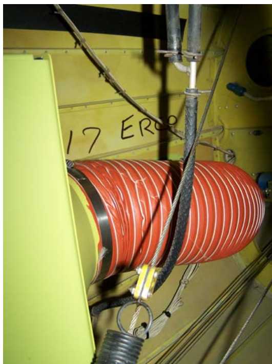
Ventilación Unid. Condensadora (Salida)
